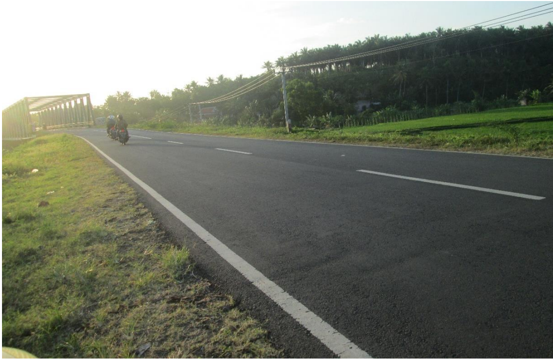
Photo 112. Horizontal Corridor of Trans SWJ Palabuanratu-Tegalbuleud-Sindangbarang-Rancabuaya-Cipatujah-Pangandaran.
