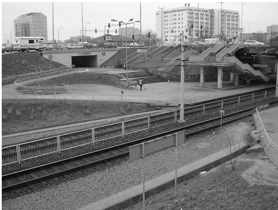
Fot. 12. Trasa PST – ruch tramwajowy odbywa się bezkolizyjnie (fot. Jędrzej Gadziński)
