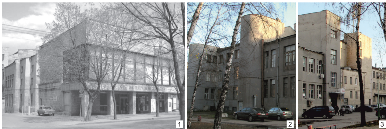
II. 1. Pałac Kultury „Piszczewik” w Charkowie (1927–1930, arch. A.W. Lineckij): 1 – widok ogólny (zdjęcie z 2000 r.), 2, 3 – fragmenty budynku od strony parku (zdjęcia z roku 2000) (fot. O. Deryabina)
