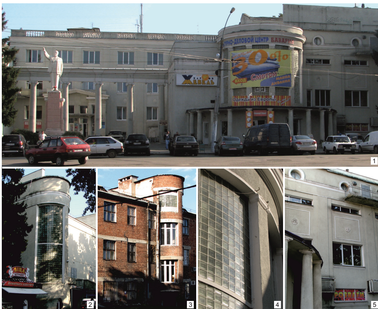
II. 2. Klub Przewoźników na Nowej Bawarii w Charkowie (Centrum Kulturalno-Biznesowe „Bawaria”) (lata 1929–1932, arch. M.S. Łuckij): 1 – widok ogólny (zdjęcie z 2011 r.), 2 – fragment budynku z boku od prospektu Ilicza (zdjęcie z 2011 r.), 3 – fragment budynku z boku (zdjęcie z 2011 r.), 4 – fragment południowego frontu (zdjęcie z 2011 r.), 5 – fragment północnego frontu (zdjęcie z 2011 r.) (fot. O. Deryabina)
