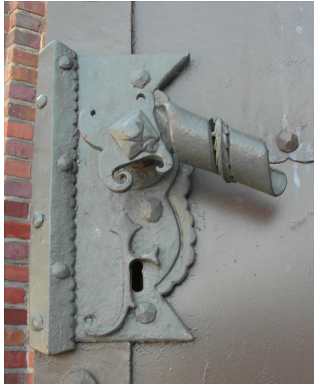
Il. 8. Klamka skrzydła drzwiowego – detal wykonano z zawiniętego płaskownika (fot. I. Machometa)
