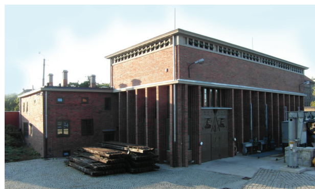
Il. 1. Elektrownia Wodna II we Wrocławiu – architektura: Max Berg, metaloplastyka: Jaroslav Vonka (fot. I. Machometa)
