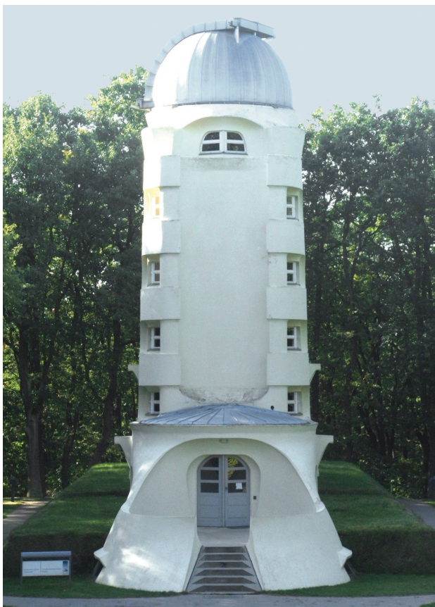
Il. 1. Erich Mendelsohn, obserwatorium astronomiczne, tzw. Wieża Einsteina, Poczdam, Niemcy, 1922 (fot. A. Serafin)
