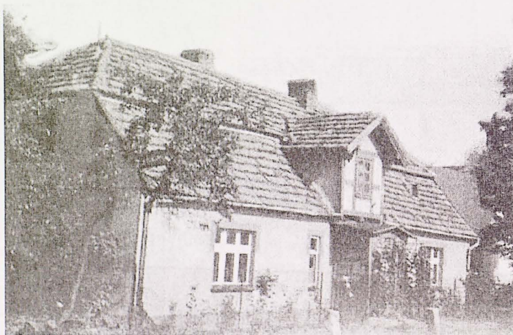
Rys. 8. Typowy niewielki dom wiejski z facjatką i drewnianym gankiem, wzniesiony około 1840 roku, przebudowany około 1900 roku (wieś Strupina nr 11)
