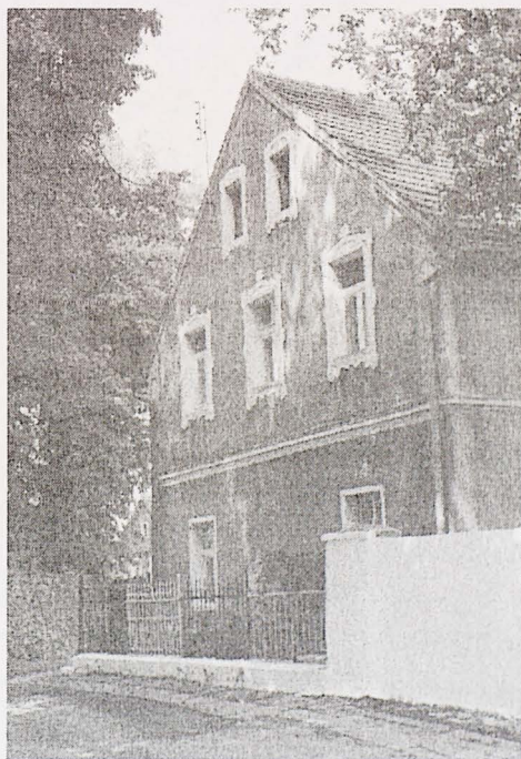
Rys. 9. Budynek we wsi Stary Wiązów nr 60 z ozdobnymi obramieniami okien Fig. 9 The farmhouse with ornamental window trims in Stary Wiązów village nr 60
