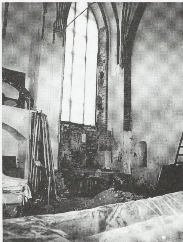
3. Dwór Artusa, widok północno-wschodniego narożnika wnętrza w trakcie badań architektonicznych w 1985 r. Widoczny kamienny cokół Wielkiego Pieca. Repr. A. Kolecki
