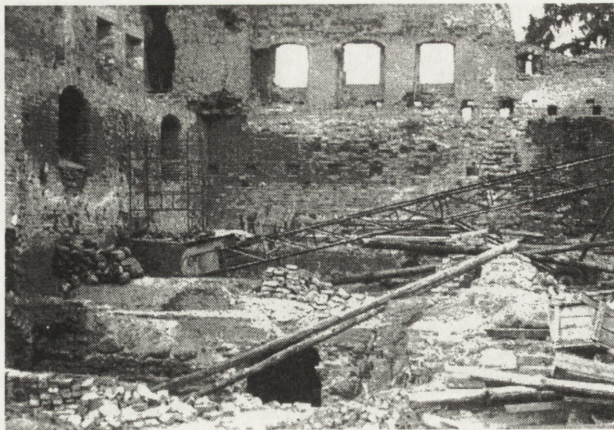
8. Naroże północno-zachodnie zamku w trakcie prac remontowych — widoczne sklepienia piwnic. Fot. J. Wańkowska-Sobiesiak, maj 1990 r.
