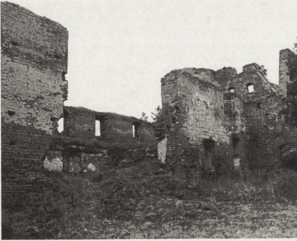
5. Resztki ścian dziedzińcowych refektarza rozebranych w 1989 r. Fot. W. Najder, 1976 r.
