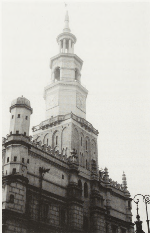
9. Stary Ratusz w Poznaniu w trakcie prac konserwatorskich. Stan zachowania w 1995 r.
