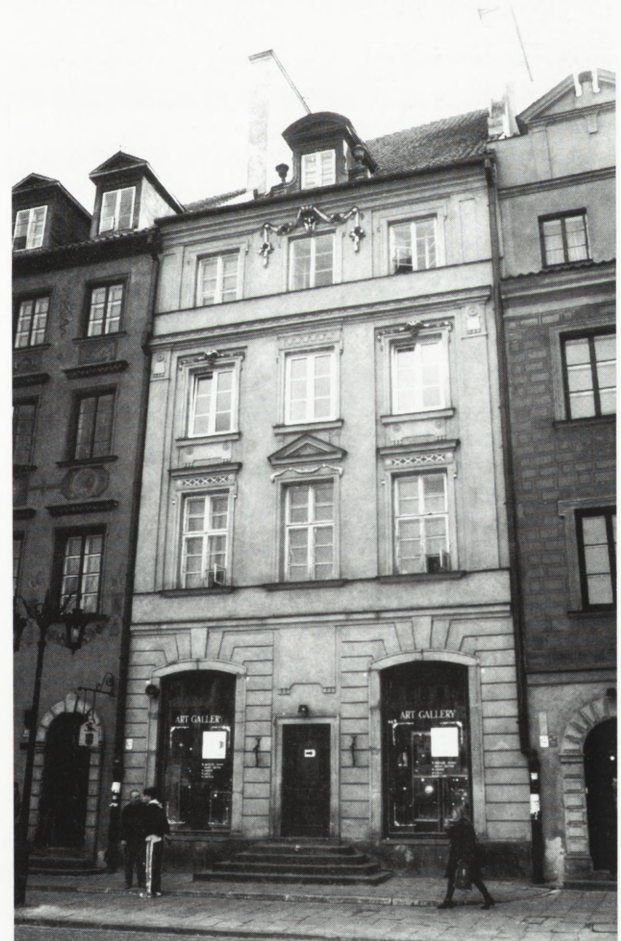
29. Warszawa, Rynek Starego Miasta 11 — w budynku wymieniono na nowe trzy okna na II piętrze
