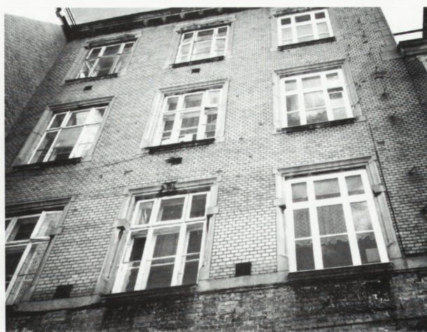
19. Warszawa, szkoła — fragment elewacji północnej
