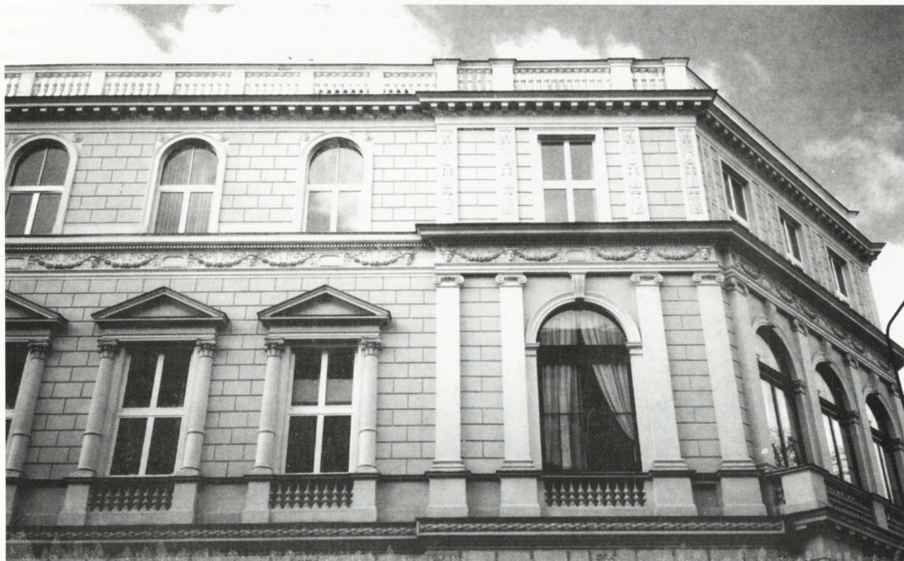
13. Warszawa, Bank Handlowy (narożnik ul. Traugutta i ul. Czackiego) — widoczny fragment I i II piętra budynku
