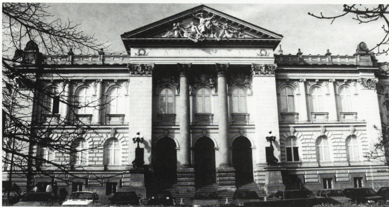
4. Warszawa, gmach Zachęty — widok ogólny elewacji od strony wschodniej
