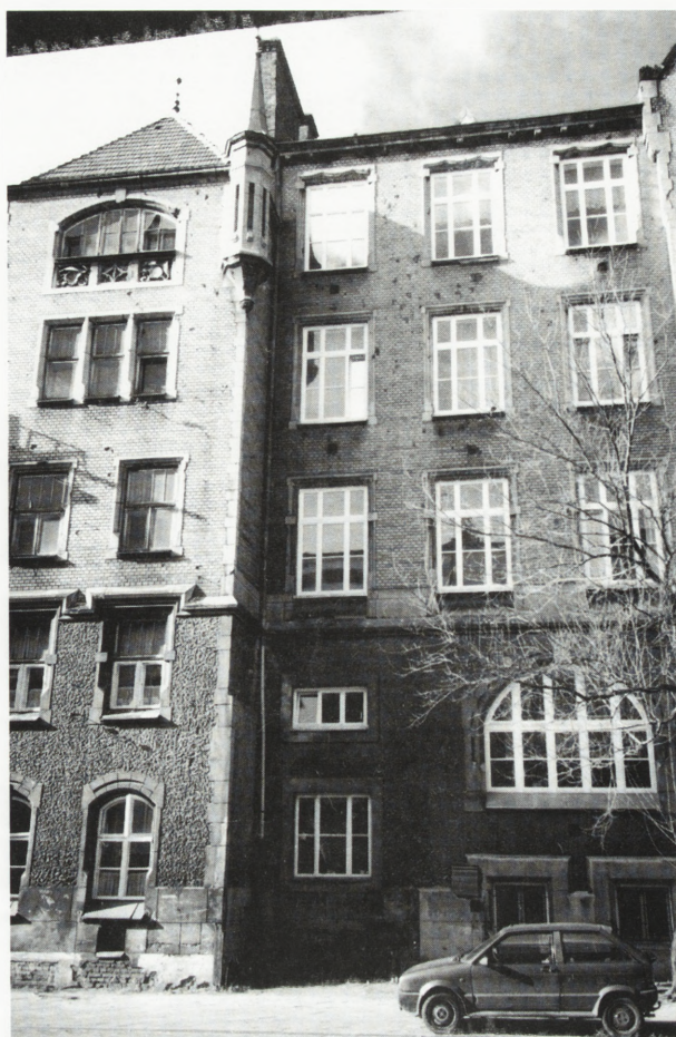
17. Warszawa, szkoła przy ul. Drewnianej 8 — fragment elewacji południowej budynku, po stronie prawej okna z nową stolarką, po lewej pozostawiona stara stolarka
