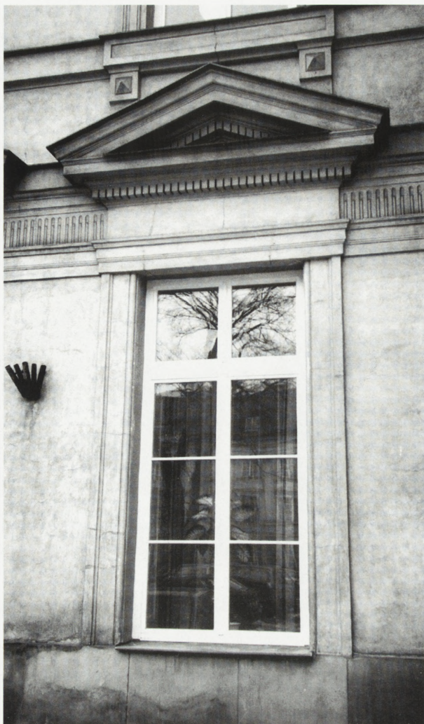
15. Warszawa, Pałac Prymasowski — współczesne okno w parterze budynku od strony elewacji frontowej
