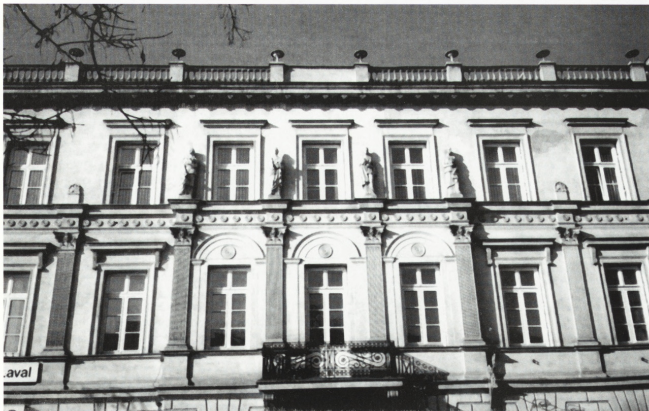
22. Warszawa, Pałac Kossakowskich — fragment elewacji od strony ul. Nowy Świat, po wymianie stolarki okiennej
