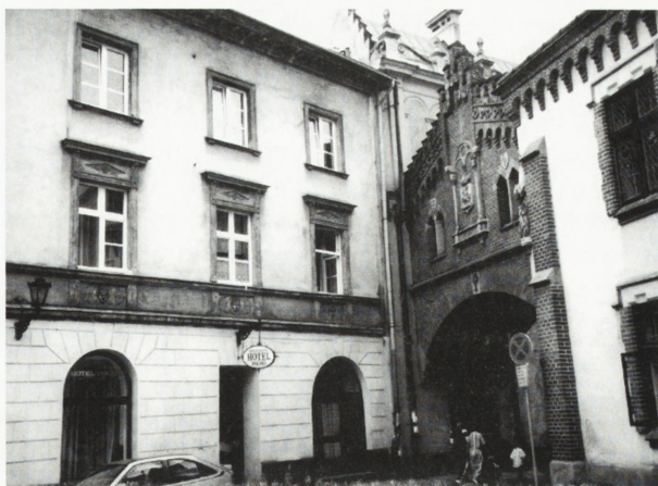
21. Kraków, Hotel Polski — współczesna stolarka okienna na I i II piętrze budynku
