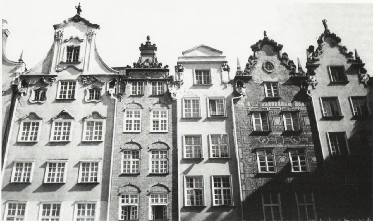
20. Gdańsk, kamienica przy ul. Długi Targ 28 — dwa współczesne okna na poziomie III piętra budynku (druga kamienica od lewej strony)
