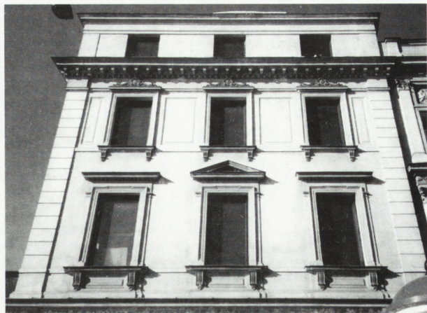
10. Warszawa, Pałac Czapskich — fragment elewacji bocznej oficyny pałacu, od strony Krakowskiego Przedmieścia
