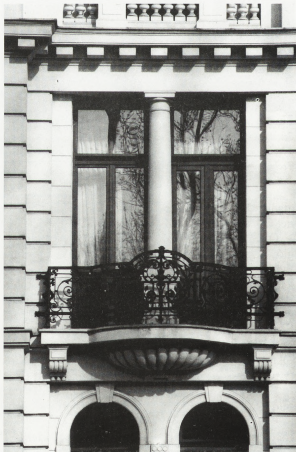
12. Warszawa, Hotel Bristol — nowa stolarka jednoramowa w porte-fenêtrach pokojów hotelowych (od strony wschodniej)
