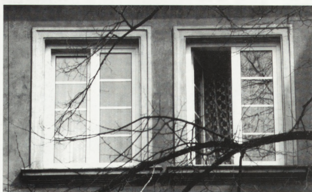
27. Warszawa, ul. Piwna 49 — zbliżenie pokazuje wymienione okna, które m.in. wyróżnia dodanie słupka poszerzającego wyraźnie pionowy podział otworu, uchylny sposób otwierania, szersze ramy oraz duże płaszczyzny szyb
