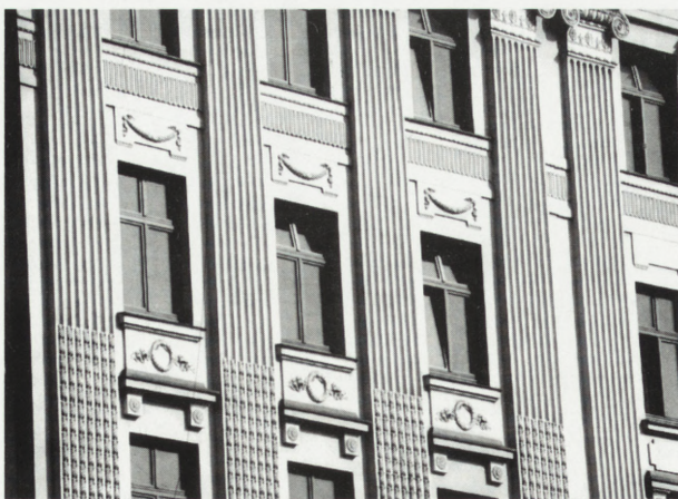
16. Warszawa, Kamienica Heurichowska — fragment elewacji południowej z widoczną nową stolarką okienną
