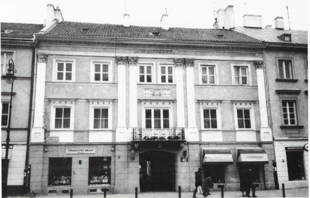
25. Warszawa, ul. Nowy Świat 40 — widok ogólny elewacji budynku, uwagę zwracają dwa nie wymienione okna (II piętro, strona prawa) oraz różnice w przyjętych rozwiązaniach podziałów stolarki w nowych oknach na I i II piętrze budynku
