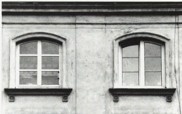
24. Warszawa, ul. Krakowskie Przedmieście 20/22 — przykład obecności na elewacji frontowej budynku okien współczesnych o odmiennych rozwiązaniach konstrukcyjnych
