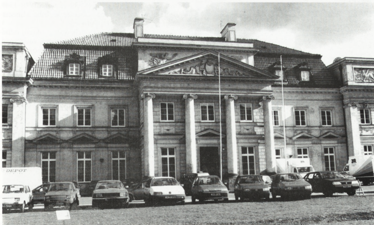
14. Warszawa, Pałac Prymasowski — ogólny widok budynku po wymianie stolarki okiennej
