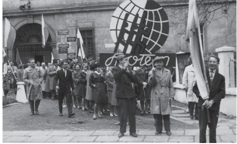
Pracownicy PSS „Społem” przed budynkiem dawnych koszar, obchody 1 Maja, lata 60. XX w.
