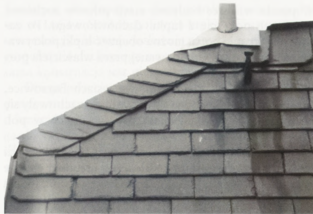
7. Ustka. Pokrycie dachu stacji pilotów w porcie 7. Ustka. Roof of pilot station in the port
