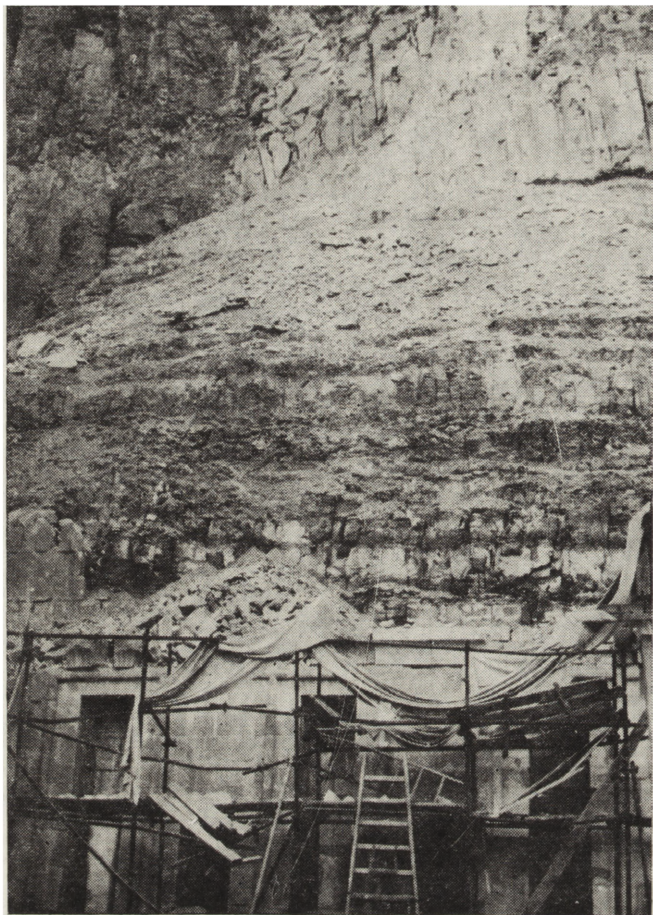
7. Świątynia królowej Hatszepsut, fragment południowego skrzydła ściany z niszami po trzęsieniu ziemi; widoczne gazy zaległe na stoku oraz część białej plamy na masywie skalnym – z tego miejsca nastąpiło oberwanie się skały
