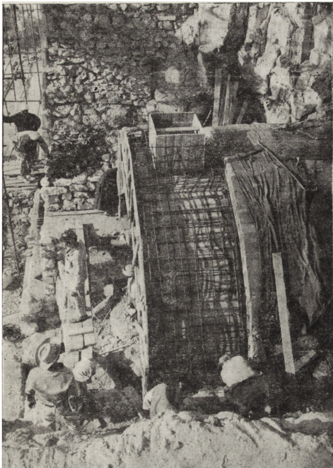
10. Świątynia królowej Hatszepsut, betonowanie żelbetowego sklepienia nad starożytną konstrukcją odciążającą sklepienie pierwszego pomieszczenia w głównym sanktuarium
