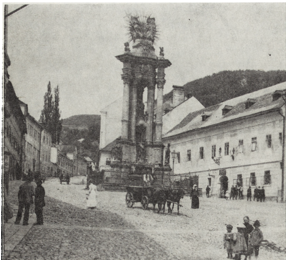
4. Bańska Stávavnica, Górný Rynek z widocznym od południa Stĺpem Morovým, stan przed rokiem 1919 (rep. J. Szandomirski)
