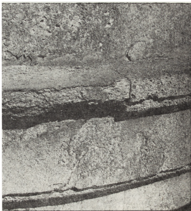
8. Bańska Szczawnica, putto ze zwieńczenia pomnika, przykład zniszczeń wystroju rzeźbiarskiego wykonanego z andezytu, stan z 1979 r. (fot. J. Szandomirski)
