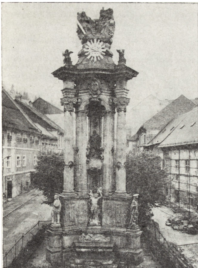
21. Słup Morowy po konserwacji, stan z 1981 r. (fot. A. Stasiak)
