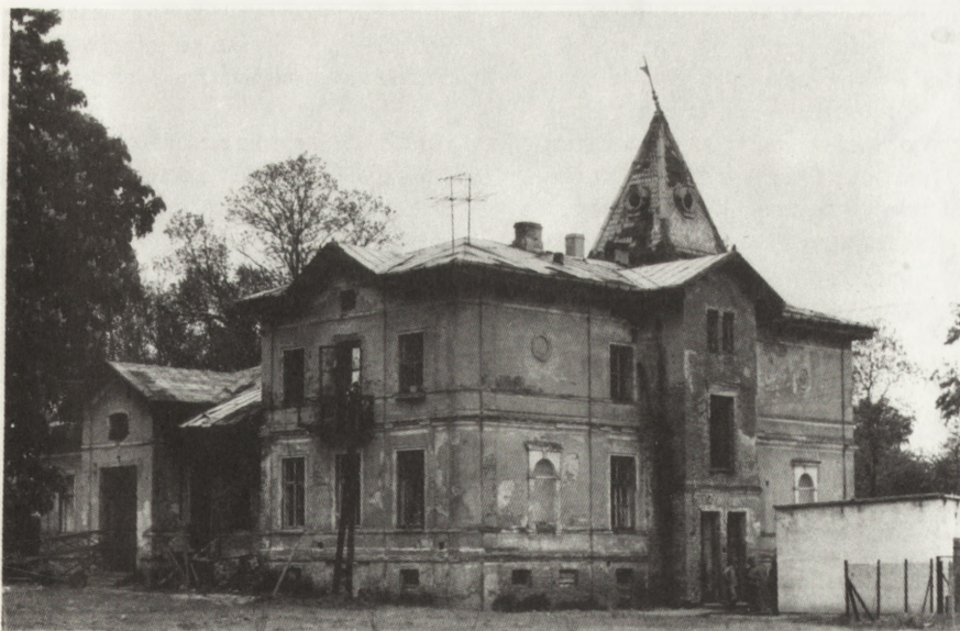
6. NIEWIKLA (gm. Sochocin) — Pałac w trakcie remontu (fot. K.Kaliściak 1980)
