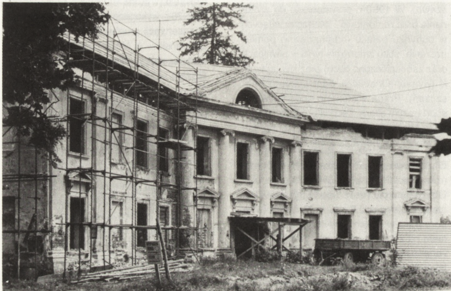
5. LUBERADZ (gm. Ojrzeń) — Pałac w trakcie remontu (fot. K.Kaliściak 1979)
