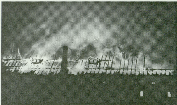
4. Płonący dach nad Wielkim Refektarzem w 1959 r. Fot. z archiwalnej fototeeki Muzeum Zamkowego w Malborku
