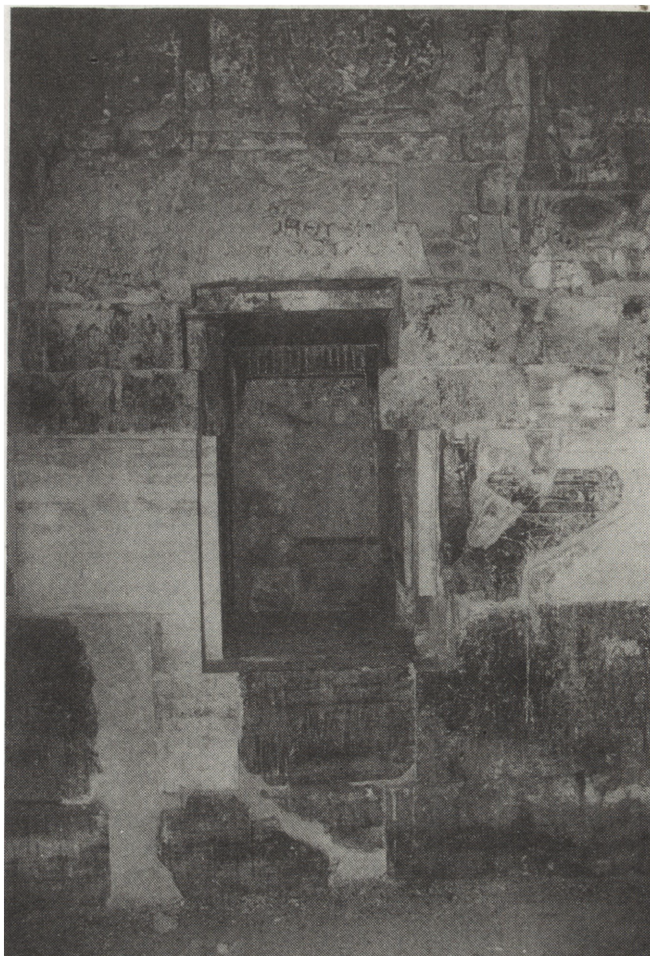
12. Nowo odkryta nisza ściany południowej pierwszego pomieszczenia głównego sanktuarium Amona, po usunięciu z niej wypełnienia
