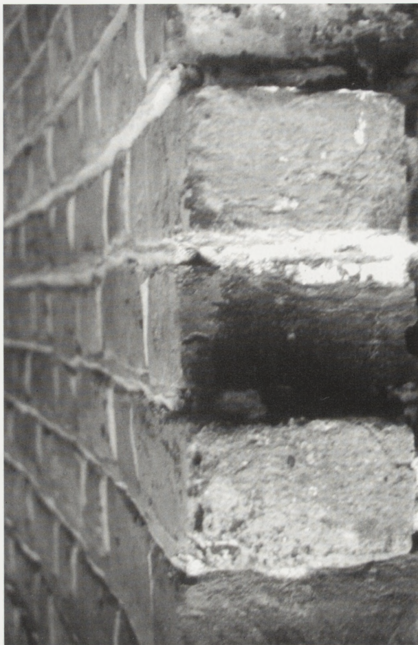
8. Przykład konserwacji współczesnego muru ceglanego — konserwacja fragmentów muru powstałych podczas wcześniejszych prac konserwatorskich i nadania im historycznej formy wraz z opracowaniem spoin, co prowadzi do zatarcia różnic między elementem oryginalnych i dodanym. Warszawa, Barbakan. Fot. J. Lewicki 1999
