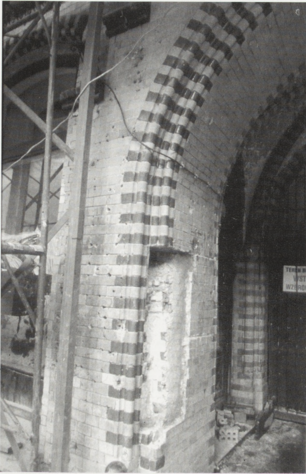
3. Fragment muru ceglanego kamienicy czynszowej w Warszawie wzniesionej z użyciem cegły pozostałej z budowy soboru na pl. Saskim. Fot. J. Lewicki 1999
