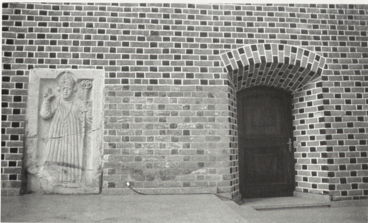
7. Przykład konserwacji muru ceglanoego — odtworzenia opracowania kolorystycznego z pozostawieniem fragmentu w formie świadka, który udowadnia błędność przyjętej koncepcji konserwatorskiej — odtworzony wzór o układzie główka-wozówka mija się z oryginalnym układem o jedną warstwę. Wrocław, kościół. Fot. J. Lewicki 1998
