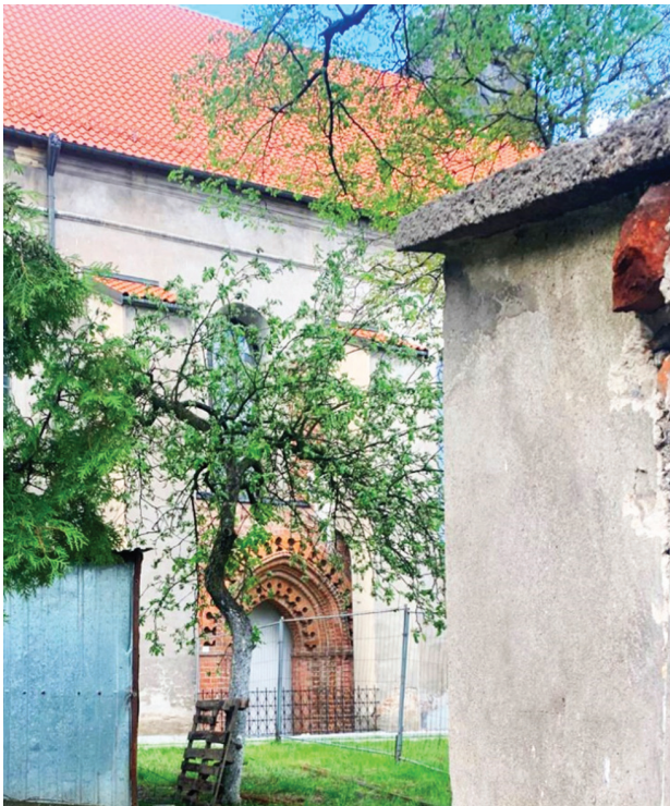
Fig. 8. View of the gothic portal (photo by A. Sowała, 2020)
