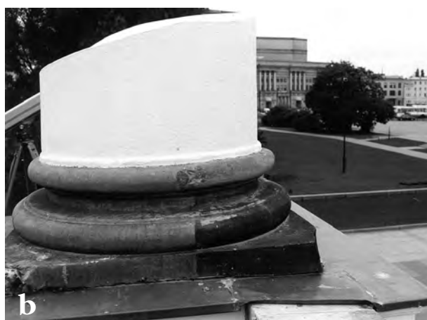
3. Fragmety czyszczonych powierzchni kamiennych podstaw pod kolumny Grobu Nieznanego Żołnierza w Warszawie
