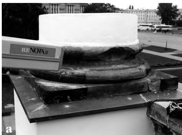
3. Fragmety czyszczonych powierzchni kamiennych podstaw pod kolumny Grobu Nieznanego Żołnierza w Warszawie
