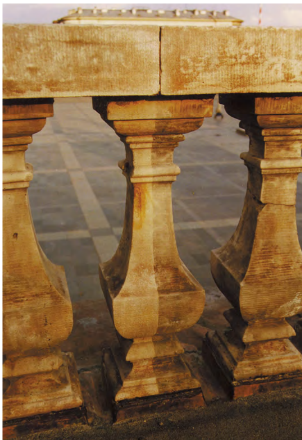
6. Powierzchnia kamiennej tralki po oczyszczeniu: jej prawa część czyszczona metodą chemiczną, a lewa część — doczyszczona laserem
