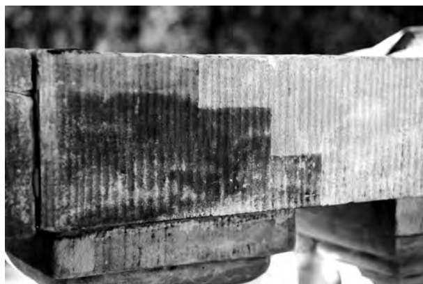
7. Zdjęcia przedstawiające fragment oczyszczonej powierzchni kamiennej balustrady na Grobie Nieznanego Żołnierza w Warszawie 7. Photographs presenting a fragment of the cleaned surface of a stone banister on the Tomb of the Unknown Soldier in Warsaw
