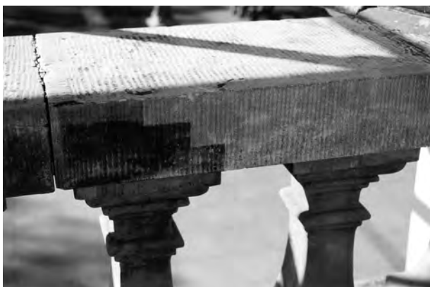
7. Zdjęcia przedstawiające fragment oczyszczonej powierzchni kamiennej balustrady na Grobie Nieznanego Żołnierza w Warszawie 7. Photographs presenting a fragment of the cleaned surface of a stone banister on the Tomb of the Unknown Soldier in Warsaw
