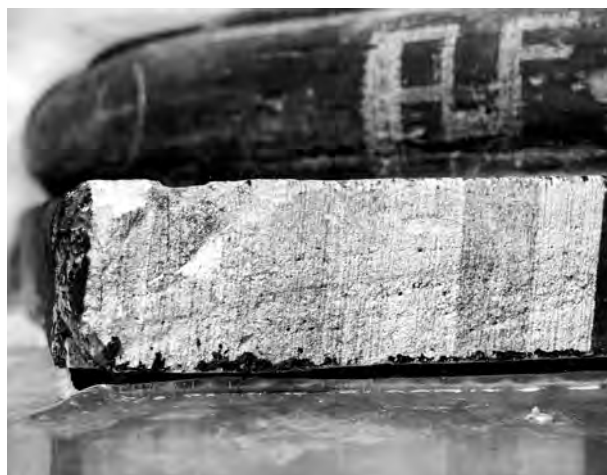
2. Fragment oczyszczonej powierzchni kamiennej podstawy pod kolumnę Grobu Nieznanego Żołnierza w Warszawie. Wszystkie fot. P. Zambrzycki
