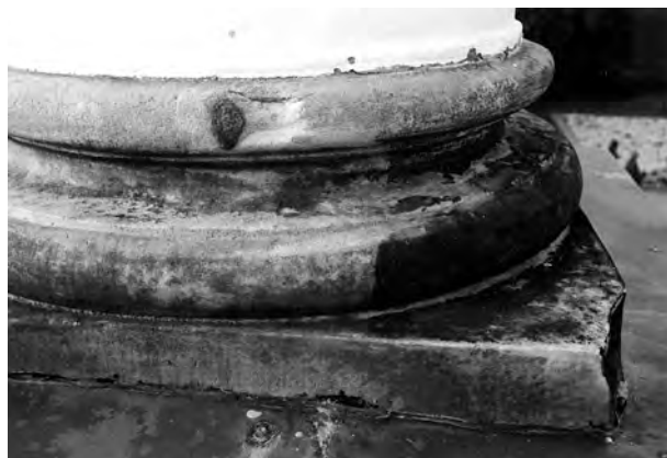
4. Fragment powierzchni kamiennej podstawy pod kolumnę oczyszczony dwiema metodami: wstępnie — laserową, a następnie metodą „kärcher”
