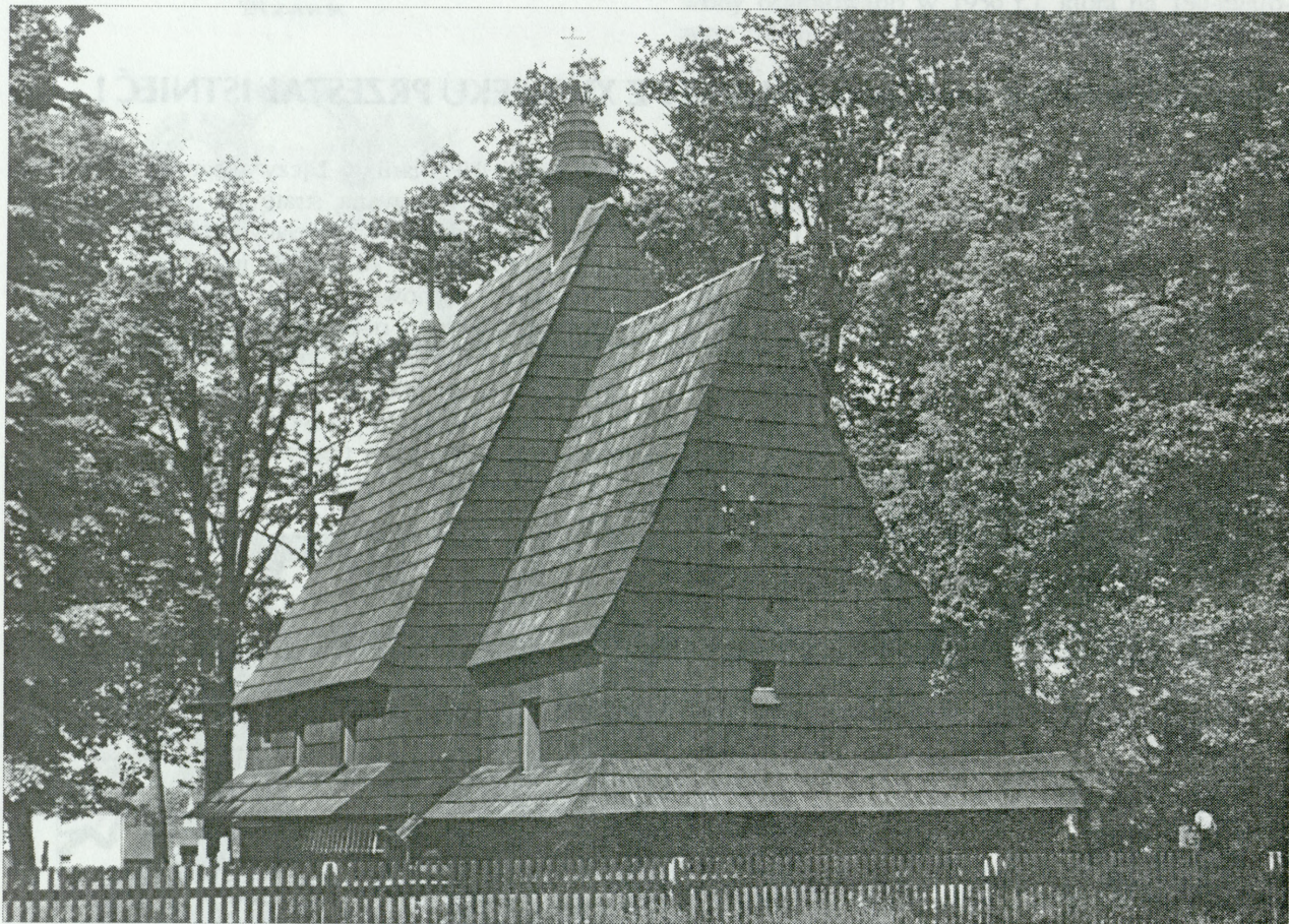
2. Kościół w Łączy, widok od południowego-wschodu. Neg. w IS PAN 2. The church in Łączy, view from the south-east. Neg in IS PAN
