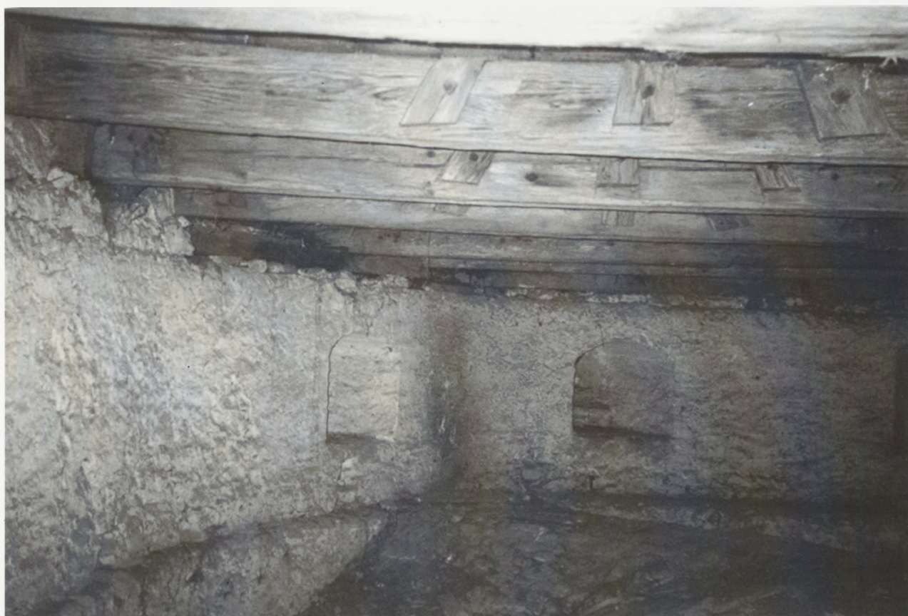
7. Galeria podstrychowa z widocznymi zamurowanymi wylotami strzelnic. Fot. P. S. Szlezynger
