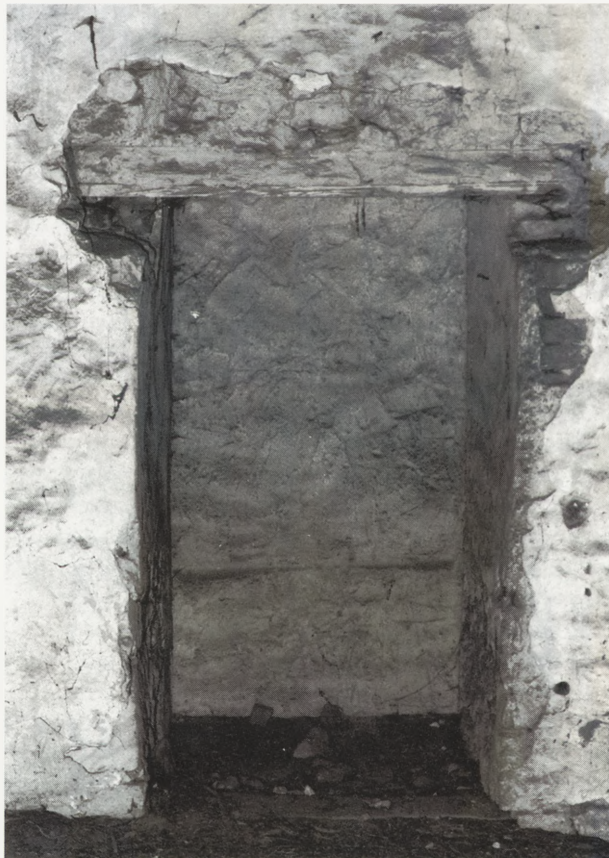
6. Zamurowany otwór drzwiowy prowadzący na obronną galerię podstrychową kościoła parafialnego, 1999 r. Fot. P. S. Szlezzynger
