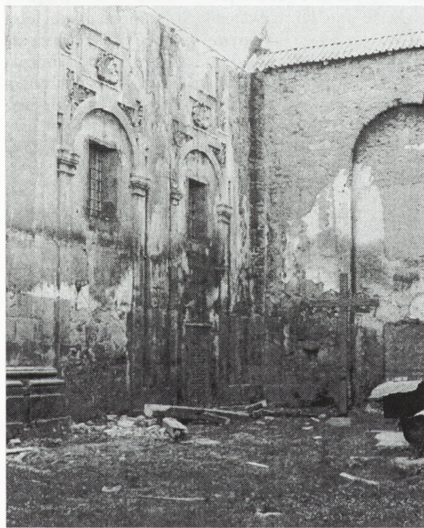
13. Wnętrze ruiny kościoła pokarmelickiego, widok na zachodnią ścianę prezbiterium i zamurowane wejście do zakrystii, 1996 r. Fot. autor
