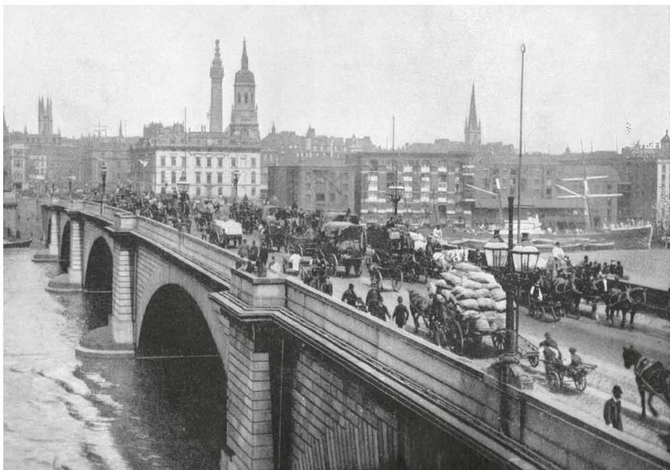
Obr. 1 Hektický provoz na Londýnském mostě okolo roku 1900 (foto J. L. Stoddard, Wikimedia Commons) / Fig. 1 Busy traffic on London Bridge around 1900 (photo J. L. Stoddard, Wikimedia Commons)
