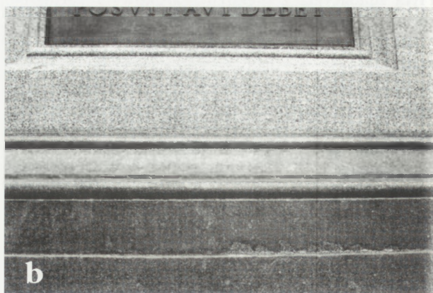
17. Gzyms kostki piedestału: a) z pozostawionymi śladami po kulach. Fot. MHW; b) po ich wypełnieniu. Fot. J. Smaza, 1994
