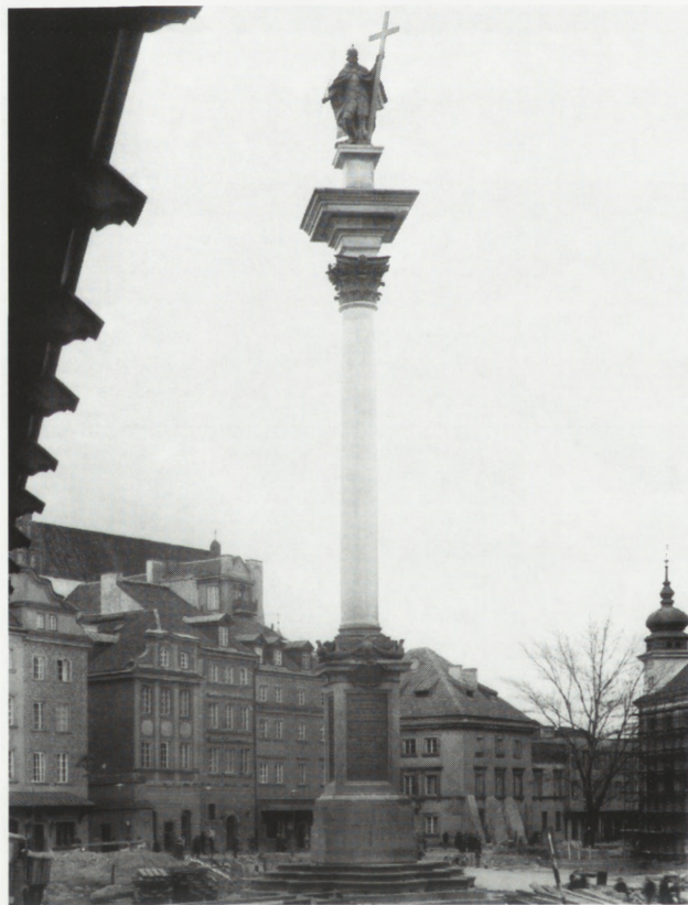
14. Kolumna Zygmunta III po pracach konserwatorskich, w trakcie montażu dodatkowych stopni. Fot. A. Juszczyk, 1977
