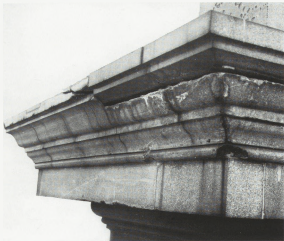
13. Impost kolumny Zygmunta III przed konserwacją w 1977 r. — odspojony flek z 1949 r. Fot. A. Stasiak
