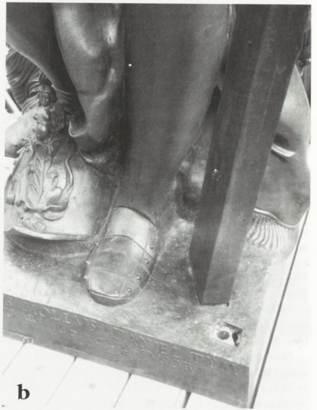
20. Podstawa posągu króla Zygmunta III: a) przed konserwacją — widoczne pęknięcia na całej jej długości; b) po konserwacji — podwyższona o ok. 3 cm. Fot. J. Mróz, 1996
