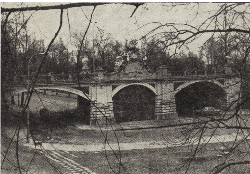
7. Warszawa, wiadukt przy ul. Karowej – zaślepienie środkowego przęsła
