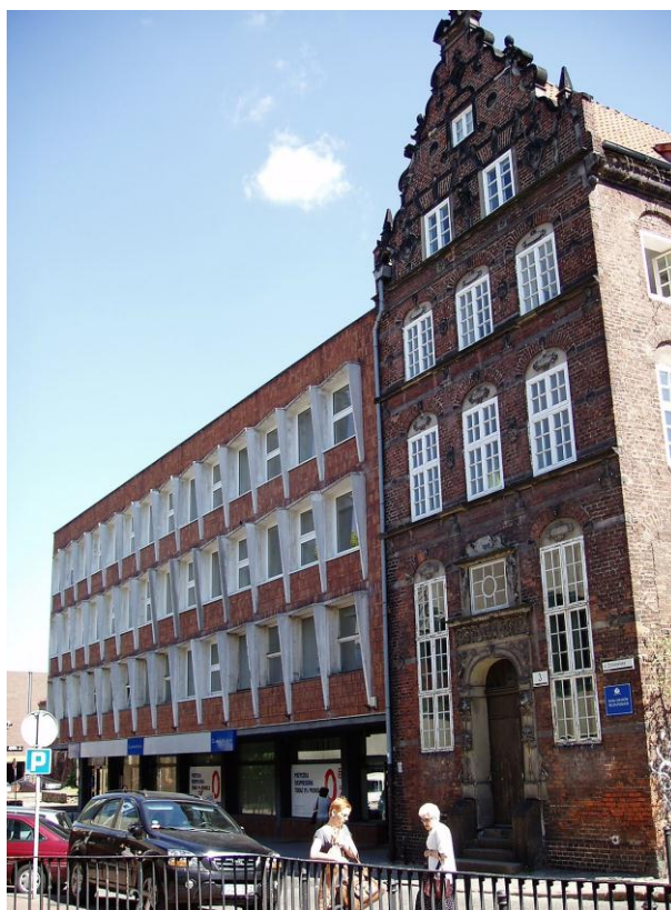
Rys. 8. Szczepan Baum, budynek Miastoprojektu w Gdańsku, 1962-1965 [fot. autor]
