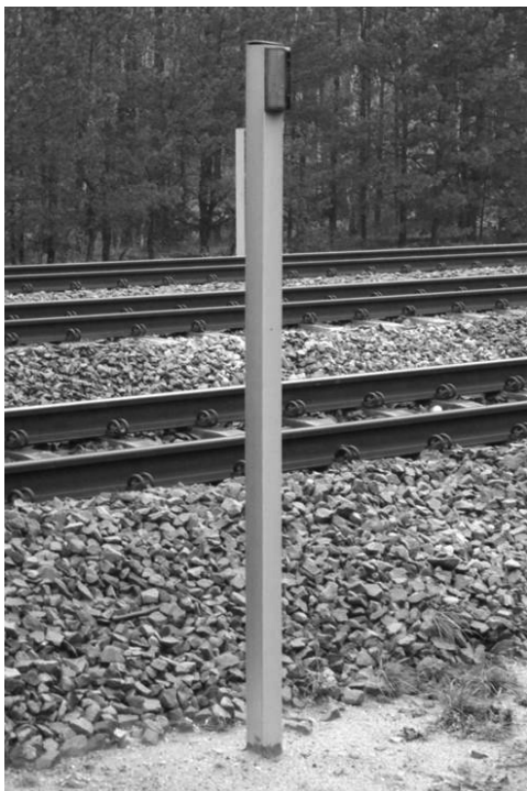
RYSUNEK 3. Zamontowany odbłask na odcinku linii kolejowej E65 (fot. K. Jasińska)
