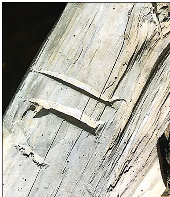
Ryc. 10. Fragment krokwi ze znakiem montażowym w formie cyfr rzymskich, rok 2020.
