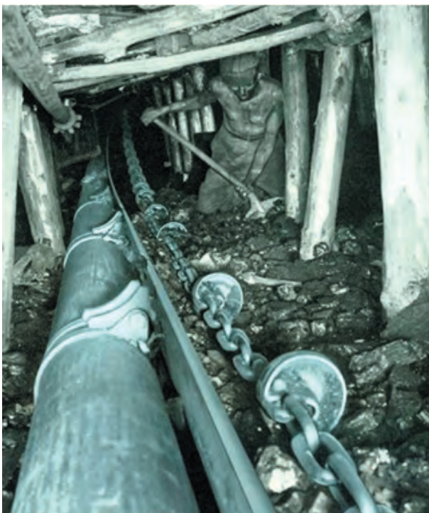
Rys. 2. Hamujący przenośnik tarczowy [4, 5, 8]
