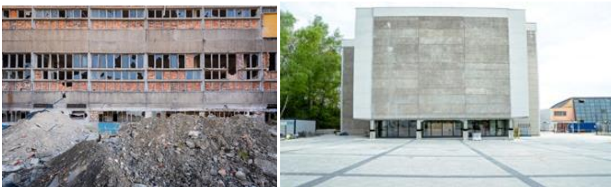
Figure 1. Łażnia Moszczenica before reconstruction.
