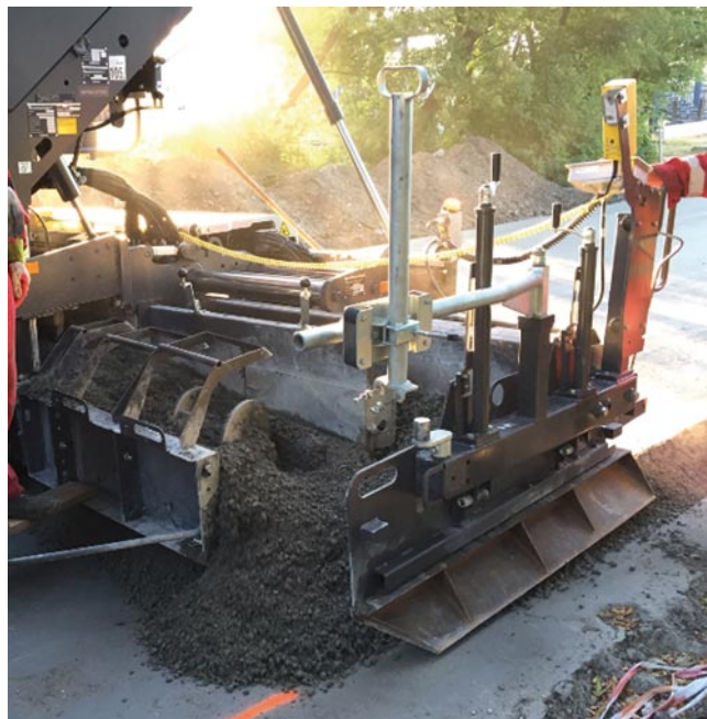
Rys. 1. Budowa nawierzchni z betonu wałowanego, ul. Makowska, Warszawa, 2018 r. [3]
