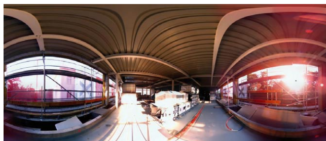
Rys. 14. Panorama ze stanowiska pomiarowego podczas skanowania konstrukcji stalowej (opracowanie własne)
