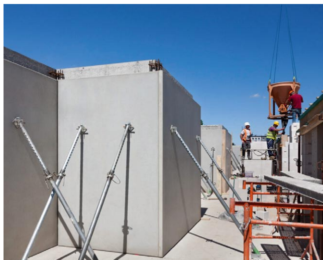
Rys. 2. Zamontowane ściany zespolone, zabezpieczone podporami ukośnymi [3]
