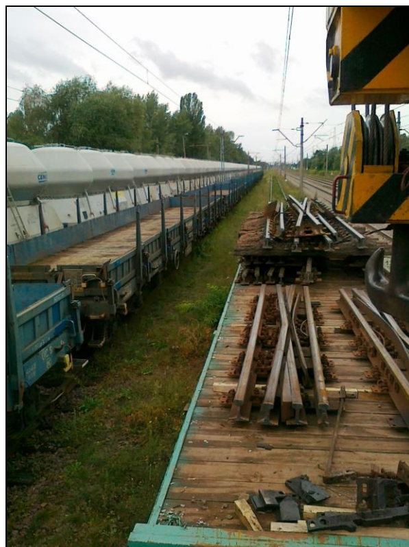
Rys. 3. Żuraw kolejowy ZU-EDK-300 w trakcie wykonywania prac torowych
