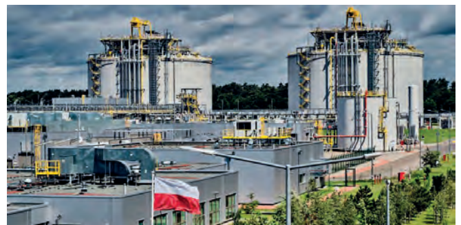
Fig. 1. LNG storage base in Świnoujście, Poland ( https://www.gaz-system.pl/pl/terminal-lng/informacje-o-terminalu-lng.html )
