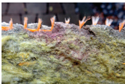
Photo 6. View of the reinforced layer from the side of the insulation where there is discoloration on the plaster surface – visible brown-purple discoloration of the adhesive mortar Fot. 6. Widok warstwy zbrojącej od strony ocieplenia w miejscu występowania przebarwienia na powierzchni tynku – widoczne brązofioletowe przebarwienie zaprawy klejowej
