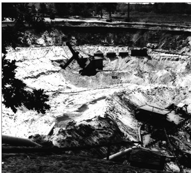
Ryc. 4. Kopalnia Siarki Piaseczno – zdejmowanie nadkładu Fig. 4. Piaseczno Sulphur Mine – overburden removal
