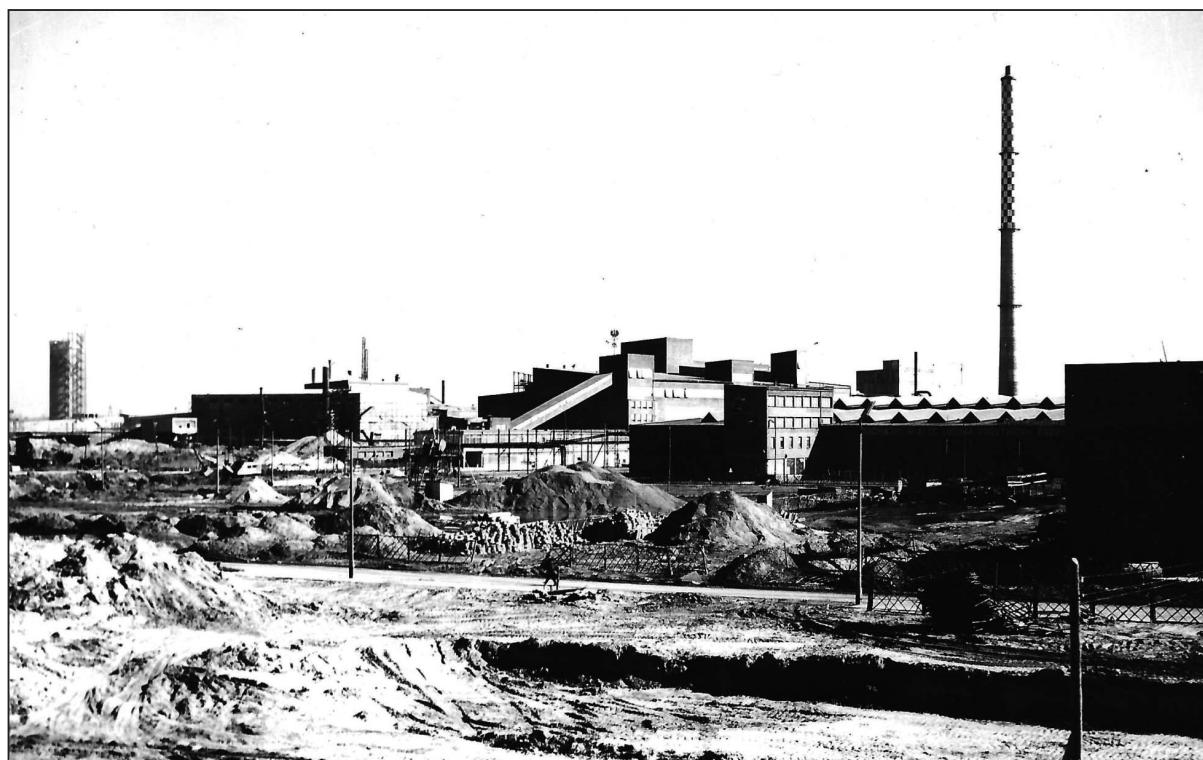
Ryc. 3. Zakład przeróbczy w budowie (ok. roku 1962)
