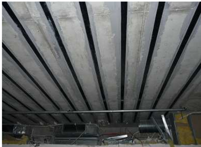
Rys. 1. Przykład wzmocnienia przy pomocy taśm węglowych.
