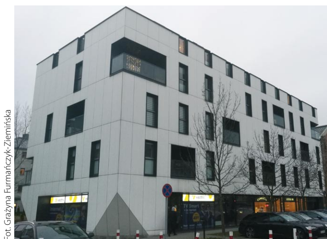
Rys. 2. Budynek z kondygnacjami niezamkniętymi ze wszystkich stron do pełnej wysokości, ale przekrytymi (loggie)
