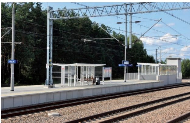
Fig. 1. Włoszczowa Pln. station on the CMK (LK 4) after modernization (16.08.2018) [photo: M. Graff]
