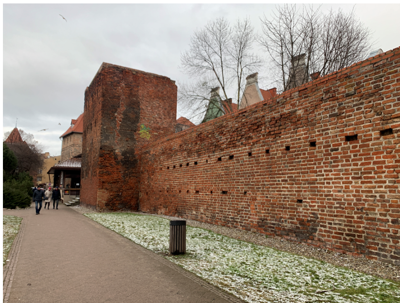
Rys. 7. Elewacja południowo-zachodnia z widokiem na Basztę i otwory maculcowe w murze [opracowanie własne]
