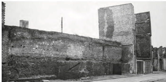
Rys. 3. Baszta Latarniana i mur po pierwszym etapie odbudowy, około 1960 r. [Archiwum PWKZ]
