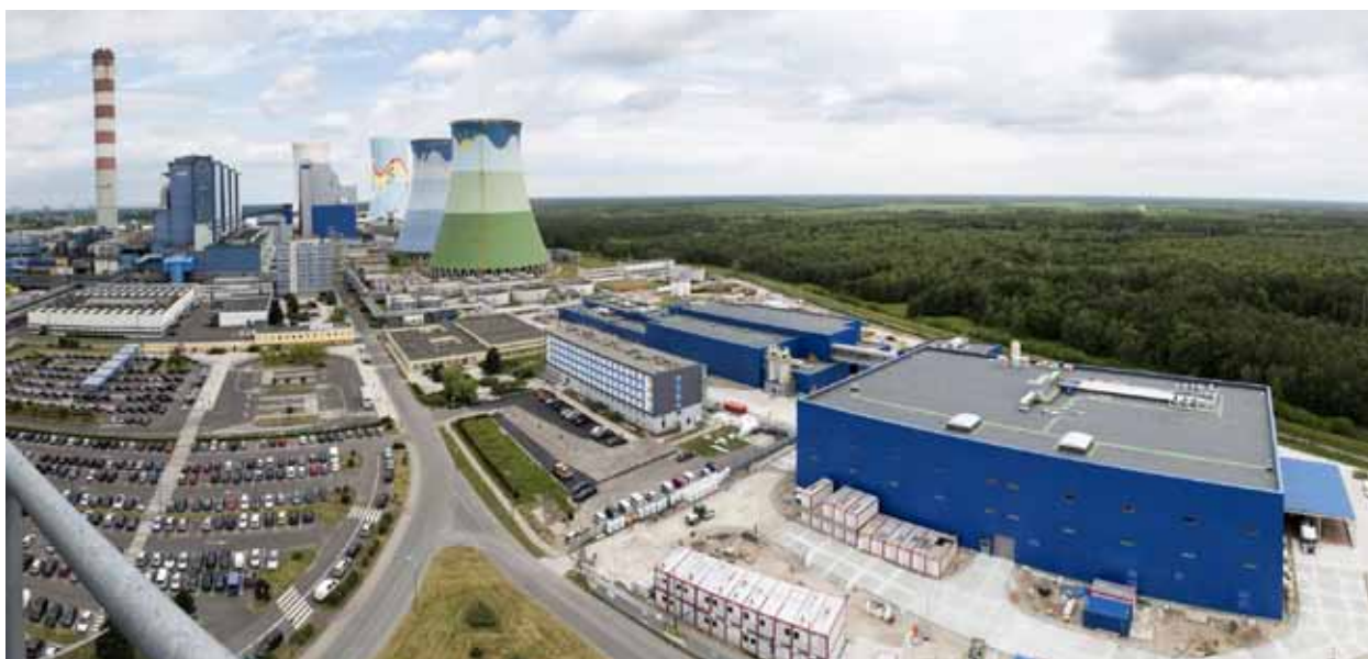
Rys. 1. Nowy SUW na Elektrowni Opole
