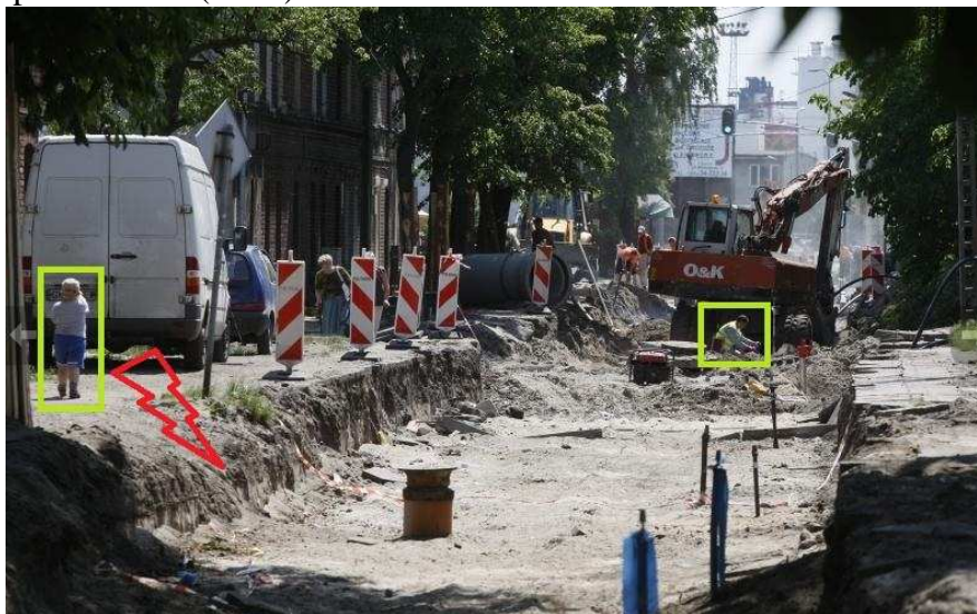
Fot. 1. Dostęp osób postronnych (dzieci) do budowy, jak również praca w bezpośrednim sąsiedztwie sprzętu ciężkiego – jedna z częstszych przyczyn wypadków śmiertelnych w budownictwie drogowym.
