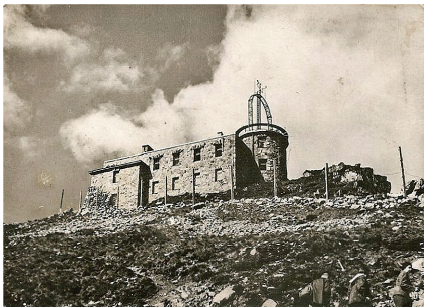
Il. 21. Obserwatorium meteorologiczne na Kasprowym Wierchu (1936–1937, proj. A. i A. Kodelscy). Fot. Tadeusz i Stefan Zwoliński, ok. 1938. MT-ZA
