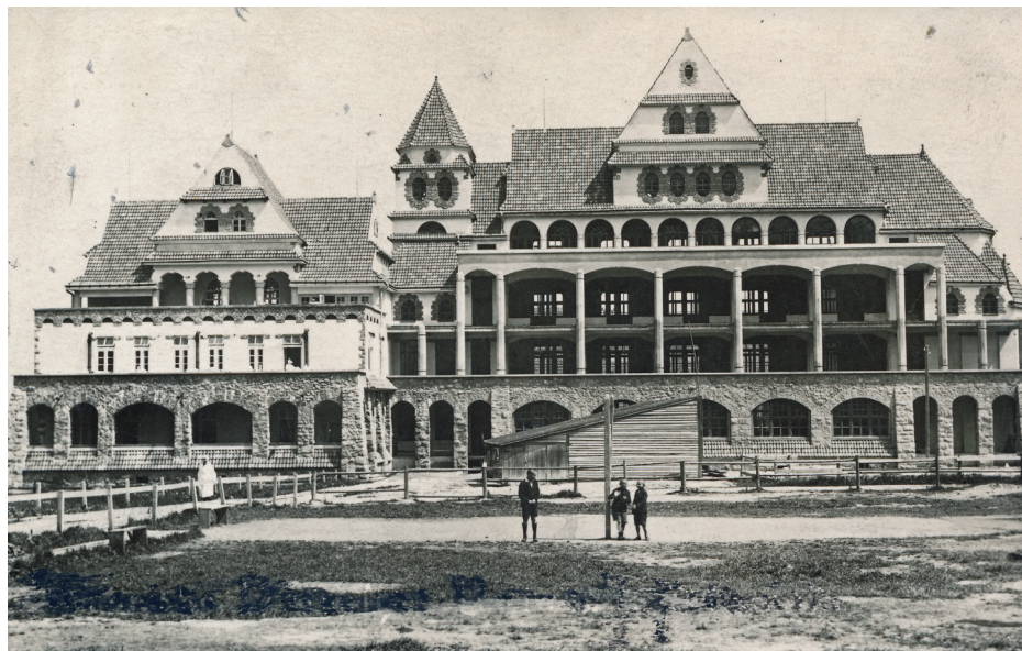
Il. 16. Sanatorium KBK na Bystrem (1922–1926–1933, proj. J. Witkiewicz-Koszczyć). Fot. Henryk Schabenbeck, MT–ZA, sygn. AF/9867/MT/II-022
