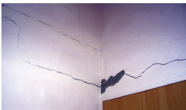
Rys. 3. Odszpajanie belek nadprożowych – budynek szkolny w województwie lubelskim
