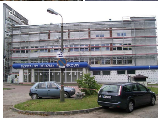
Rys. 1. Przykłady rusztowań: a) wejście i stanowiska pracy w Hodyszewie, b) konstrukcja wsporcza płyty pomostowej w Budach Łańcuckich, c) platforma robocza w KWK Pawłowice, d) rusztowanie podwieszane w Lublinie (zdjęcia własne)
