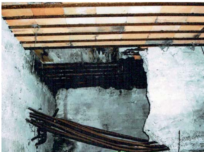
Fot. 5. Suchy Most na Zalewie rzeki Bug w Terespolu: a) widok z boku, b) filar z izbicą, c) uszkodzenia dźwigarów głównych – stan w 2003 r. [8]
