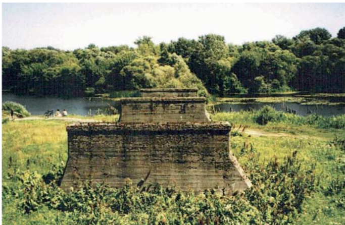
Fot. 7. Podpory mostu przez Bug od strony Polski w pobliżu drogi Terespol – Bohukaty – Kukuryki, stan w 2005 r. [8]
