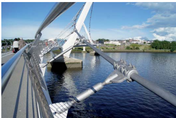
Fot. 1. Kładka Peace Bridge w Londonderry w Północnej Irlandii: a) widok kładki z boku; b) widok kładki wzdłuż pomostu; c) widok wieszaków o regulowanej długości [1]
