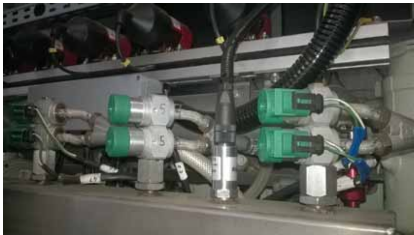
Rys. 6. Układ zasilania gazami poprodukcyjnymi silnika 12-cylindrowego
