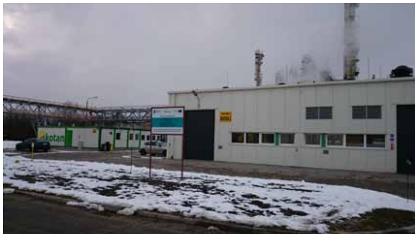
Rys. 1. Obiekty wzniesione na terenie Zakładów Azotowych ZAK Kędzierzyn-Koźle na potrzeby instalacji pilotażowej wykorzystującej gazy poprodukcyjne dla potrzeb energetycznych
