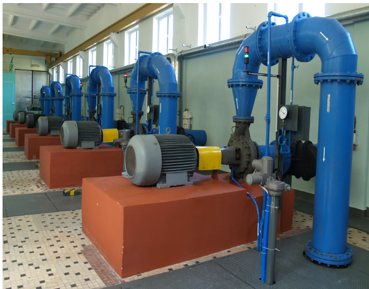
Rys. 1. Widok stacji pomp
